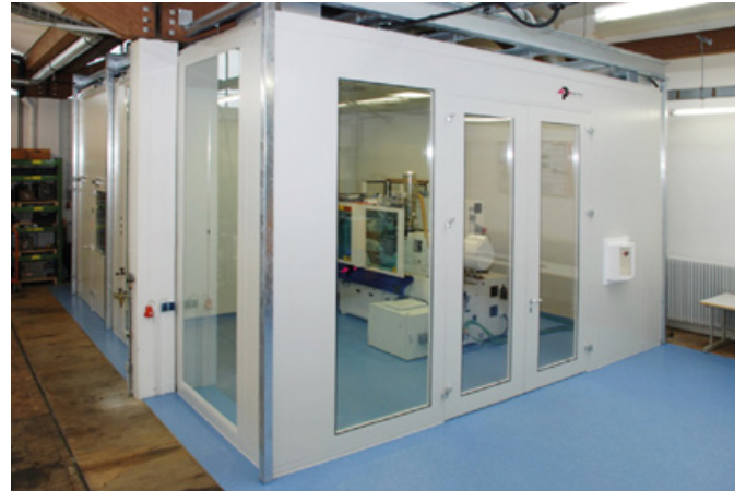
Abbildung 1: Reinraum nach Fertigstellung und Maschineneinbringung 2010.
