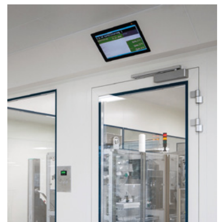
Abbildung 1: Flächenbündige In-Wall Montage ohne Frontplatte.
