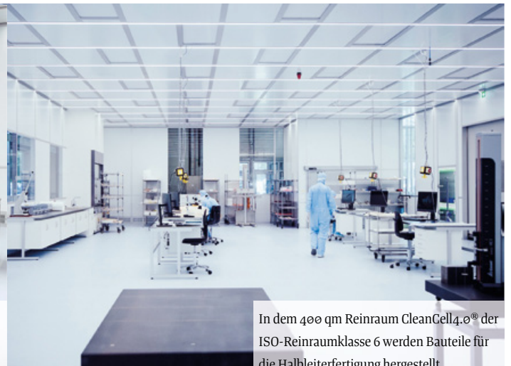
Spezielle Reinraummöbel und Rolltore mit berührungsloser Ansteuerung sorgen für sichere Prozessabläufe.
