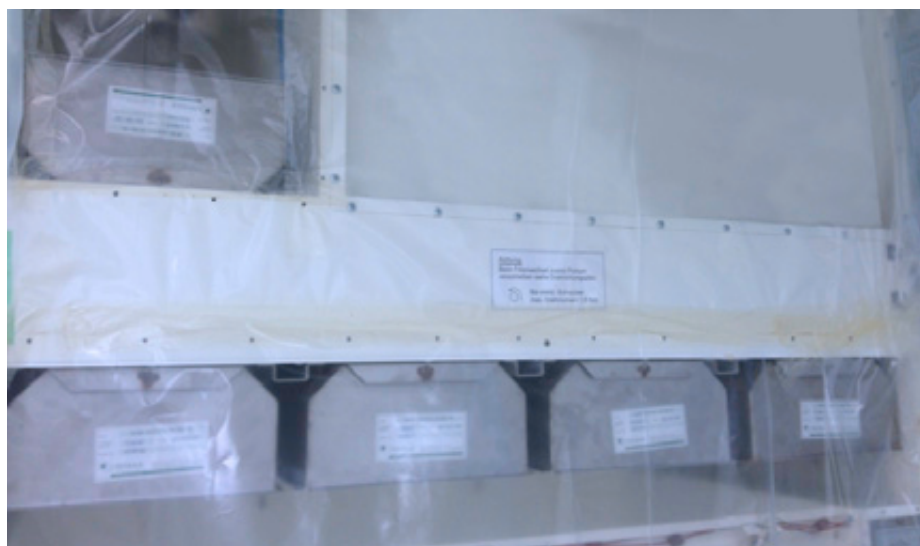
Original patentierte Herstellerfilter. Bei der TÜV Typprüfung freigegeben. VA-Filtereinheiten können zum Tausch geschlossen werden, kontaminationsarmer Filterwechsel möglich.
