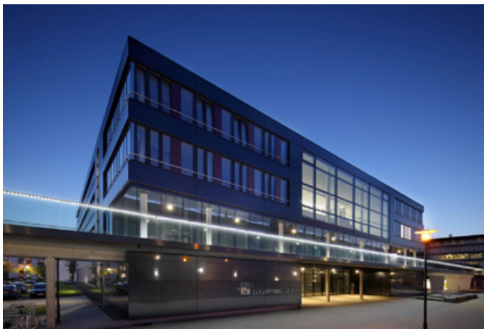
Für die Entwicklung von innovativen Geschäfts- und Lösungskonzepten im Bereich der Automatisierung und Digitalisierung investiert Weidmüller in einen neuen Standort in unmittelbarer Umgebung der Universität, des Fraunhofer IEM und der Zukunftsmeile 1 in Paderborn (Copyright: Universität Paderborn).
