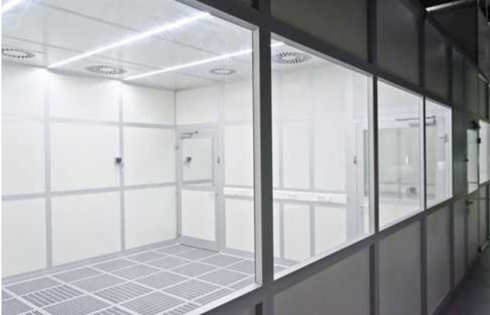
Bild 1: Forschungs-Reinraum mit turbulenter Verdünnungsströmung (TVS)
