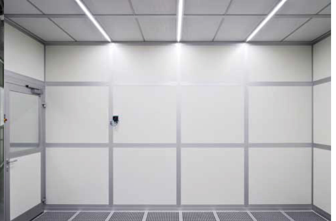
Bild 2: Forschungs-Reinraum mit turbulenzarmer Verdrängungsströmung (TAV)
