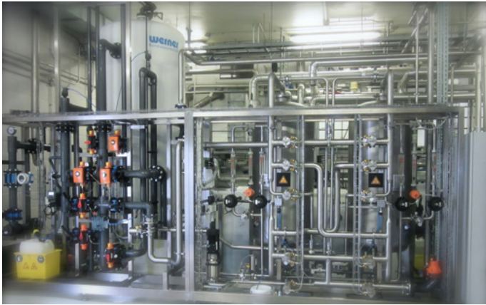
Werner Enthärtungsanlage, serielle Gegenstromtechnik, 18 m 3 /h thermisch sanitisierbar. ©Werner GmbH 2016.
