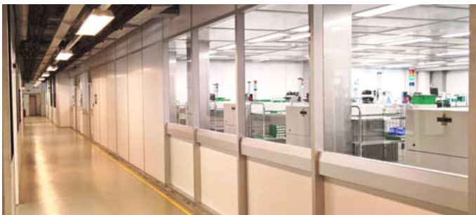
Aussenansicht des Reinraumsystems CleanCell 4.0®.
