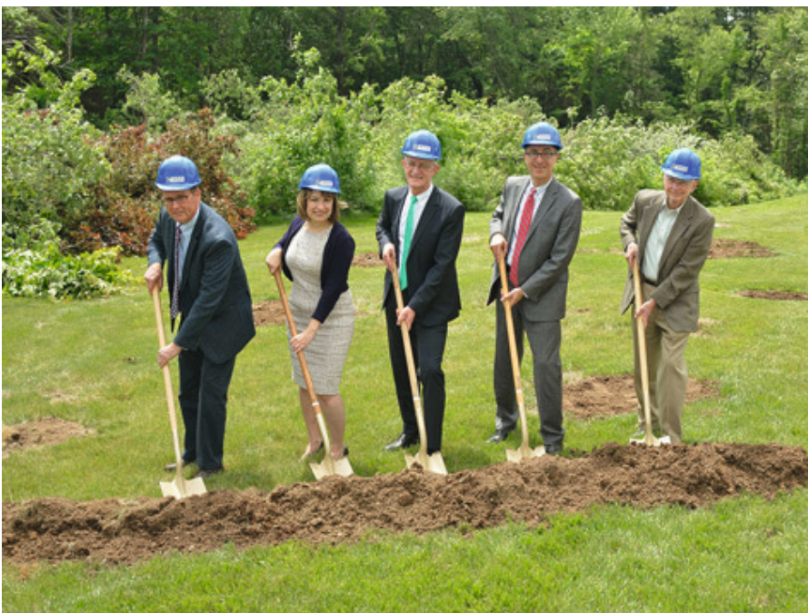
Spatenstich für den Erweiterungsbau von Arburg am US-Standort in Rocky Hill (v. l.): Jim Becker, Projekt-Architekt Tecton Architects, Claude-Helene McIntyre, CFO Arburg Inc., Friedrich Kanz, Geschäftsführer Arburg Inc., William O'Sullivan, stellvertretender Bürgermeister von Rocky Hill und Larrye deBaer, Vorsitzender der Economic Development Commission, Rocky Hill. (Foto: Arburg)
