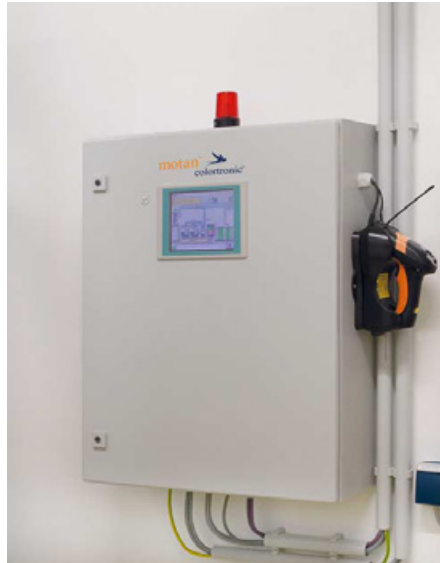
Mit dem Handscanner müssen Behälterwechsel angemeldet sowie die Material- und Chargencodes von neuen Oktabins eingelesen werden. (Foto: motan-colortronic)
