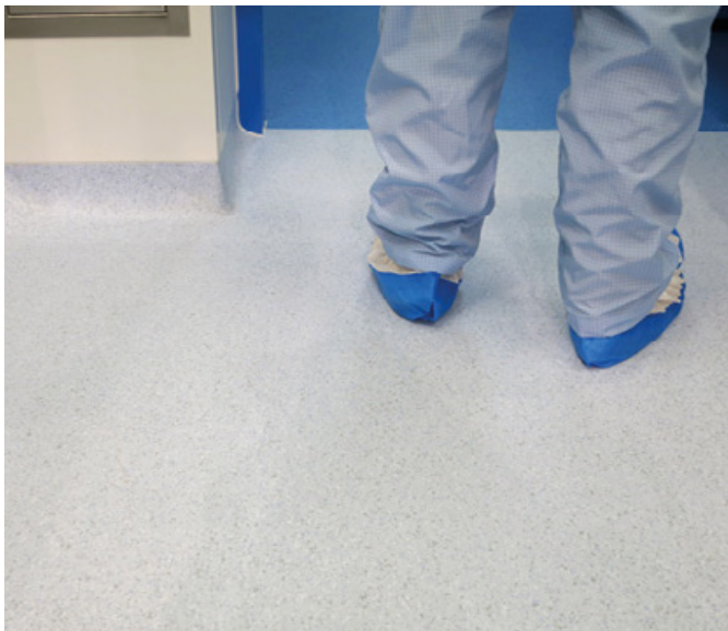
Abb. 3: Ecken mit 90°-Winkeln lassen sich nur sehr schwer reinigen. Es kommt zu Anlagerung von Kontaminationen in den Winkeln, die nicht durch das Wischverfahren erreicht werden (sogenanntes Rundwischen der Ecken und Winkel). Eine optimale Gestaltung der Übergänge, hier beispielsweise zwischen Wand, Tür und Fußboden, können ohne großen Aufwand mit einem Bodenwischbezug ausgewischt werden. (Quelle: enicos e.K. engineering und Gerflor Mipolam GmbH)
