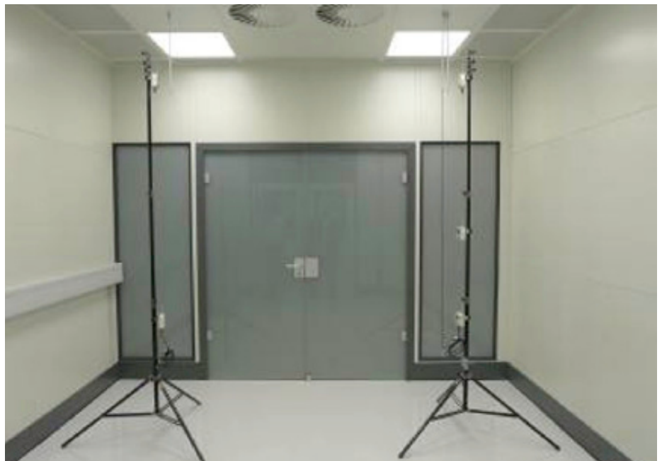
Der wesentliche Vorteil der Lampen für den Systemraumbau liegt darin, dass sie die Wärme nicht nach unten in den Raum, sondern nach oben abgeben, wo der Abluftstrom sie abtransportiert. Dadurch sind sie besonders gut für temperaturstabile Messräume geeignet.
