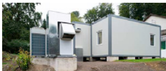
Der insgesamt 50 m 2 große Reinraum wurde in den Dresdner Produktionsstätten der WISAG ausgebaut und dann nach Osterode transportiert.
