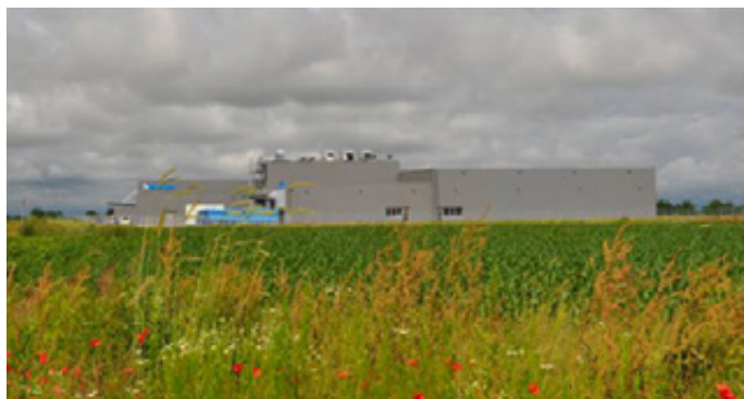
Da die Produktionsgebäude am Hauptsitz in Bahlingen zu klein geworden waren, baute die Braunform GmbH in der Nachbarstadt Edingen einen neuen Standort mit zwei Reinräumen für die Kunststoff- und Pharmaproduktion. (Quelle: Braunform GmbH)
