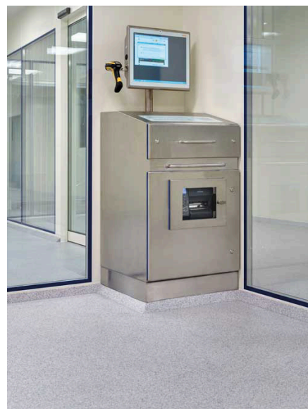
Der Vorteil des Reinraumbodens: Maximale Flexibilität. Denn erst nach der Verlegung werden die Innenwände aufgestellt. (Bildnachweis: © LEONHARD WEISS)
