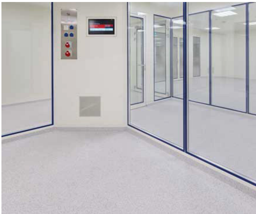
Der Boden besteht aus einem Granulat, das direkt auf der Baustelle mit einem Bindemittel zu einem homogenen Mörtel vermischt und als eine einzige durchgehend fugenlose Bodenfläche aufgetragen wird. (Bildnachweis: © LEONHARD WEISS)
