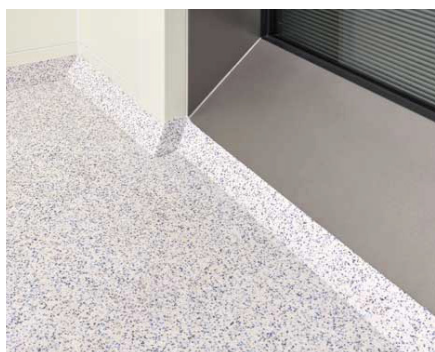
Nach dem Aufstellen der Wände lassen sich die Wandanschlüsse ebenfalls mit der pastösen Granulat-Bindemittel-Mischung und der Versiegelung in einem zweiten Schritt realisieren. (Bildnachweis: © LEONHARD WEISS)
