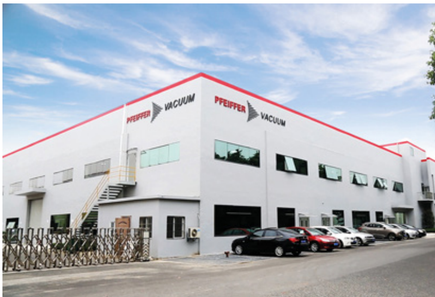
Das neue Werk von Pfeiffer Vacuum in Wuxi, China.
