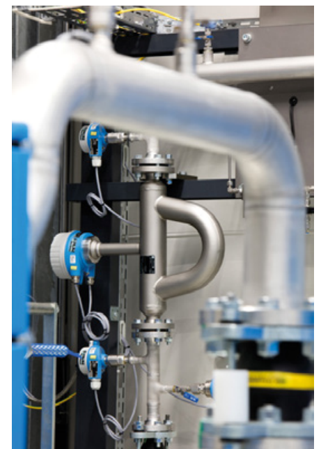
Fig. 2: Grande précision de mesure du débit massique et de la densité, pour les crèmes glacées en vrac ou d'autres fonctions dans le processus d'analyse. (Photo: Endress + Hauser)
